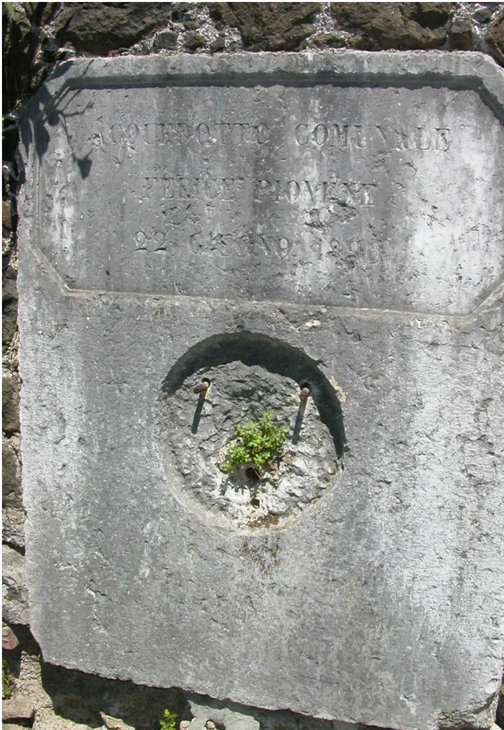
Pietra sull'ultimo fontanino del vecchio acquedotto Piovene
