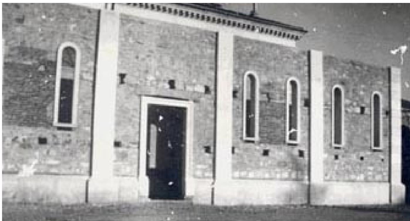
Ampliamento della chiesa di Santo Stefano
